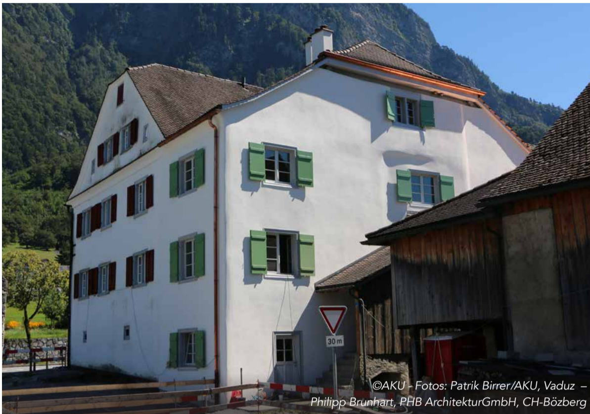
Das restaurierte Wohnhaus im Winkel in Balzers
