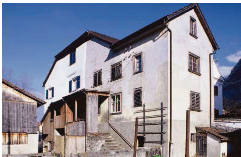
Das Gebäude vor der Sanierung noch im Dornröschenschlaf.
