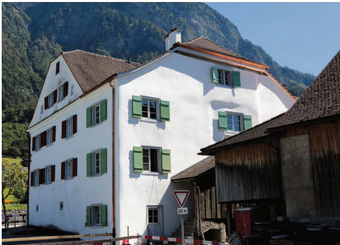
Neu herausgeputzt: Der Gebäudeteil zum Haus im Winkel 1/3 nach soeben erfolgter Instandsetzung.
